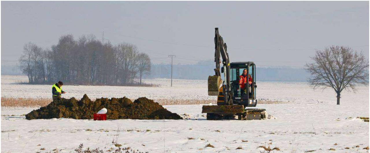
Mit einem Bagger wird Boden ausgehoben auf dem Grund der ehemaligen Deponie im Rißtal. Die Erde wird auf Altlasten untersucht. Fotos: Andreas Spengler
